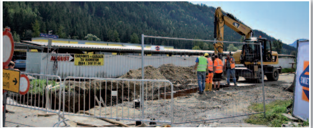
In der Gewerbesiedlung haben nun die Baumaschinen das Sagen.
